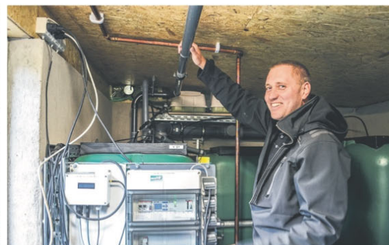
Marcus visar avloppsröret som leds in i membranet.
